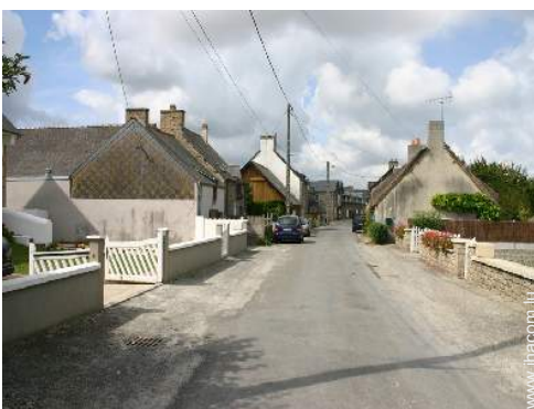
vue sur rue/avenue
