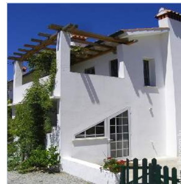
terrasse sur toit
