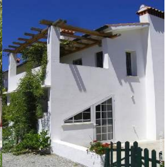
terrasse sur toit
