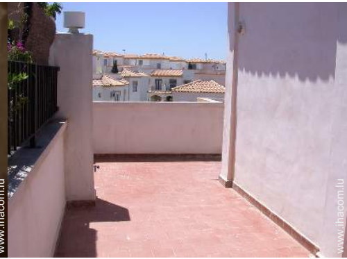
terrasse sur toit
