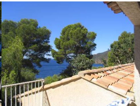
vue depuis la terrasse sur toit
