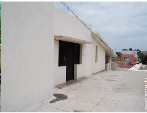
terrasse sur toit
