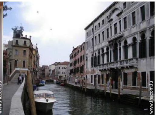
Maison de canal de Charme
